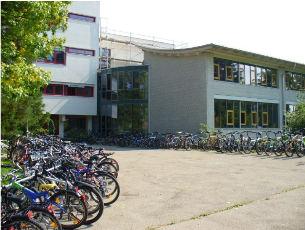
Schulzentrum Döchtbühl - kein Wetter und Diebstahlschutz (Maßnahme 52)
