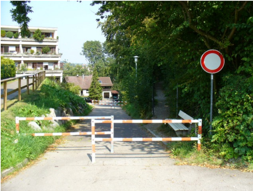
Wolpertsheimer Weg, Schulweg (Maßnahme 50)
