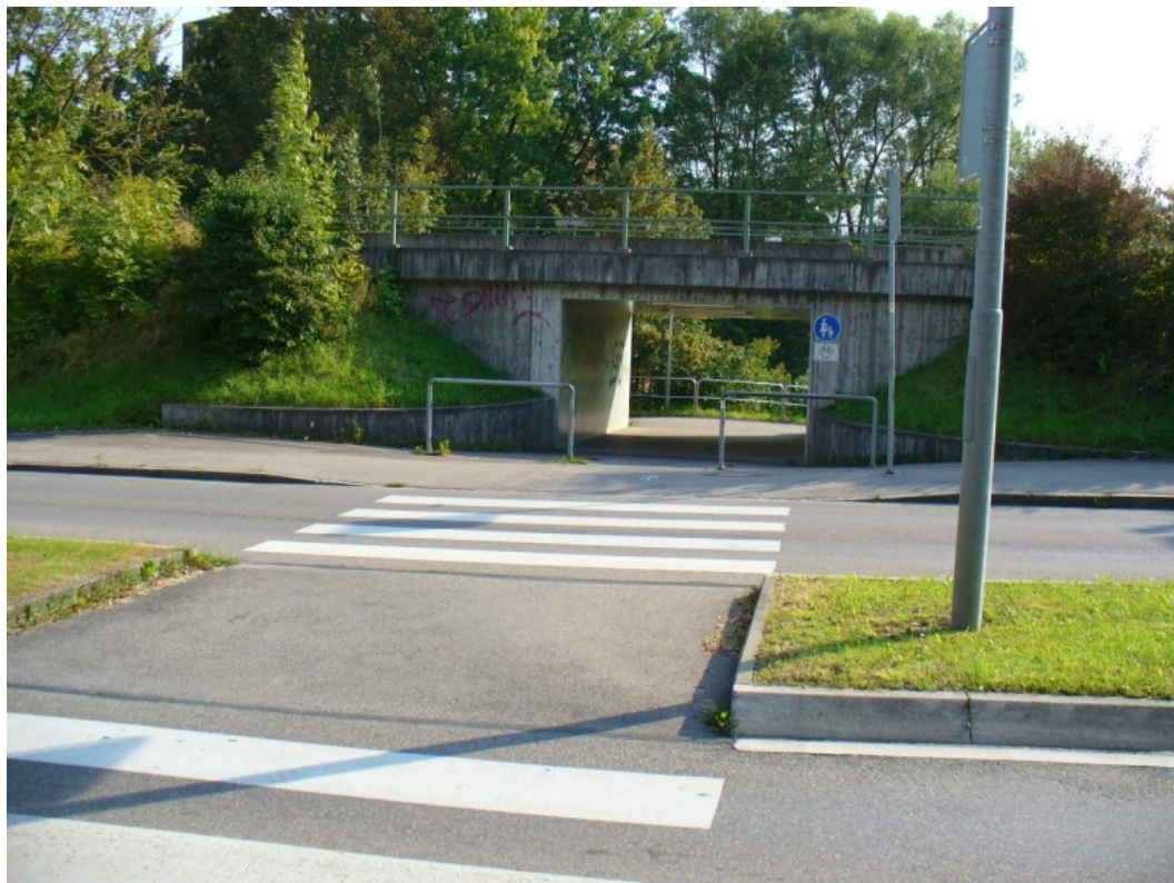
Querungshilfe und Mitnutzung von Gehwegen, Schützenstraße
